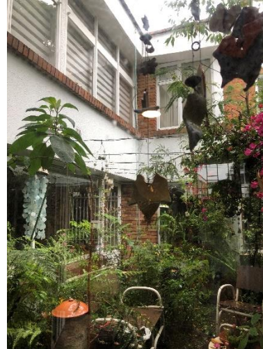
Fotografía 14. Fotografía del aislamiento posterior y fachada posterior del inmueble ubicado en la Calle 118 No.70C-69 IN 2. Fecha fotografía. Marzo 12 de 2021
