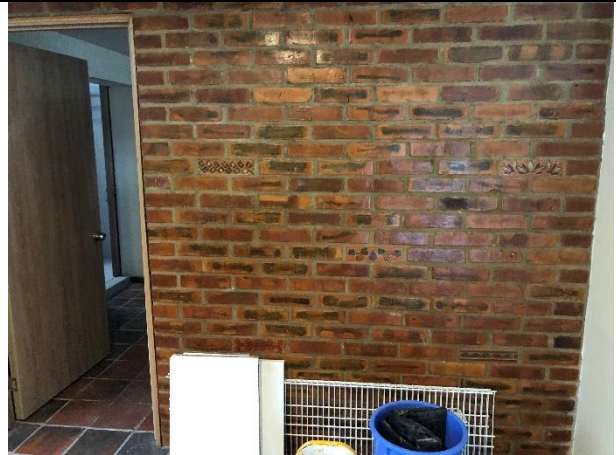
Fotografía 12. Fotografía al interior de una de las áreas ubicadas en el primer piso en la parte posterior del inmueble ubicado en la Calle 118 No.70C-69 IN 2. Fecha fotografía. Marzo 12 de 2021
