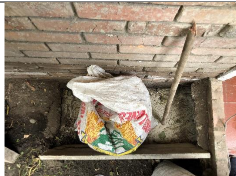
Fotografía 10. Fotografía del antejardín y del muro exterior de la fachada norte del inmueble ubicado en la Calle 118 No.70C-69 IN 2. Sobre esta área por debajo de la capa vegetal se realizó la construcción de pilotes y vigas de transferencia. Fecha fotografía. Marzo 12 de 2021
