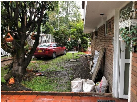
Fotografía 9. Fotografía del antejardín y del muro exterior de la fachada norte del inmueble ubicado en la Calle 118 No.70C-69 IN 2. Sobre esta área por debajo de la capa vegetal se realizó la construcción de pilotes y vigas de transferencia. Fecha fotografía. Marzo 12 de 2021
