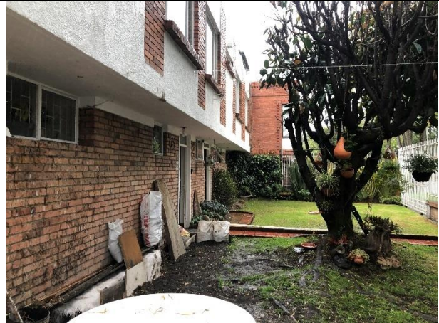
Fotografía 8. Fotografía del antejardín y del muro exterior de la fachada norte del inmueble ubicado en la Calle 118 No.70C-69 IN 2. Sobre esta área por debajo de la capa vegetal se realizó la construcción de pilotes y vigas de transferencia. Fecha fotografía. Marzo 12 de 2021
