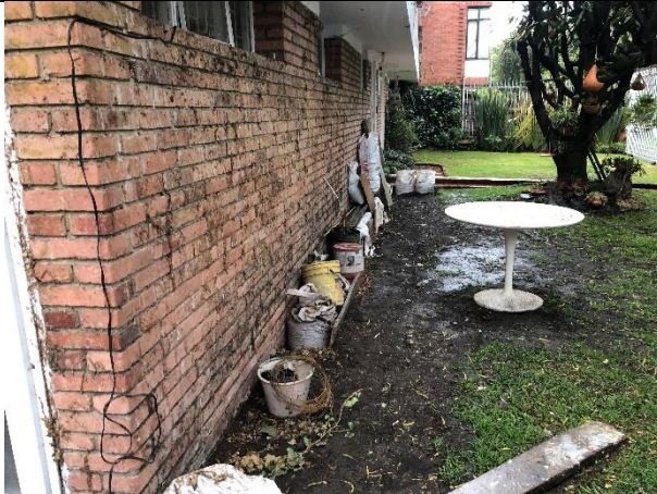
Fotografía 7. Fotografía del antejardín y del muro exterior de la fachada norte del inmueble ubicado en la Calle 118 No.70C-69 IN 2. Sobre esta área por debajo de la capa vegetal se realizó la construcción de pilotes y vigas de transferencia. Fecha fotografía. Marzo 12 de 2021
