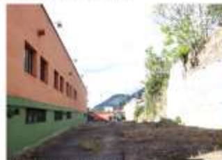
Vista inferior hacia el norte. Fuente: Visto IDPC, Septiembre 2019.
