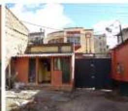
Vista inferior hacia el sur.
