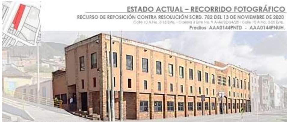
Fuente: Visto IDPC, Septiembre 2019.
