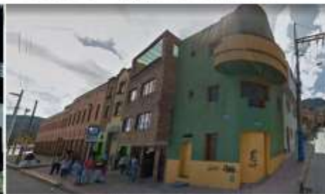
Edificio de las Américas, construido en 1992. Instituto Geográfico Agustín Codazzi, 2012
